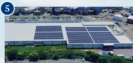
【所在地】大阪府 【業種】ホームセンター
